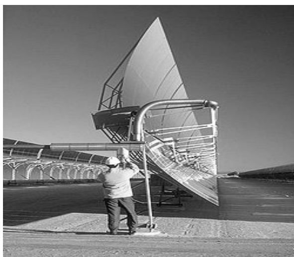
شکل ۳- مقیاس صنعتی آینه‌های سهموی خطی
